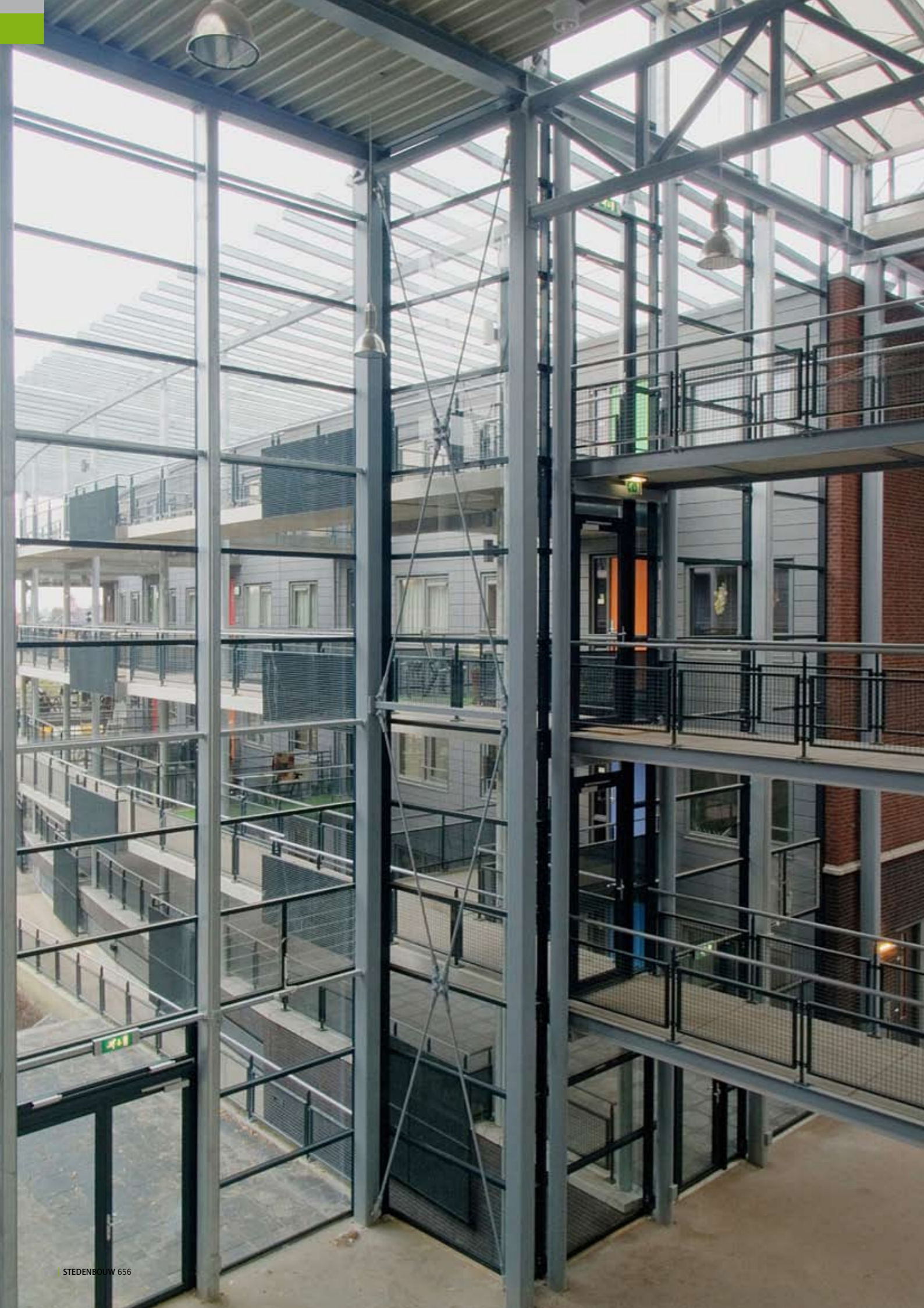
Vrij dragende constructie: het atrium tussen de koop- en huurappartementen
